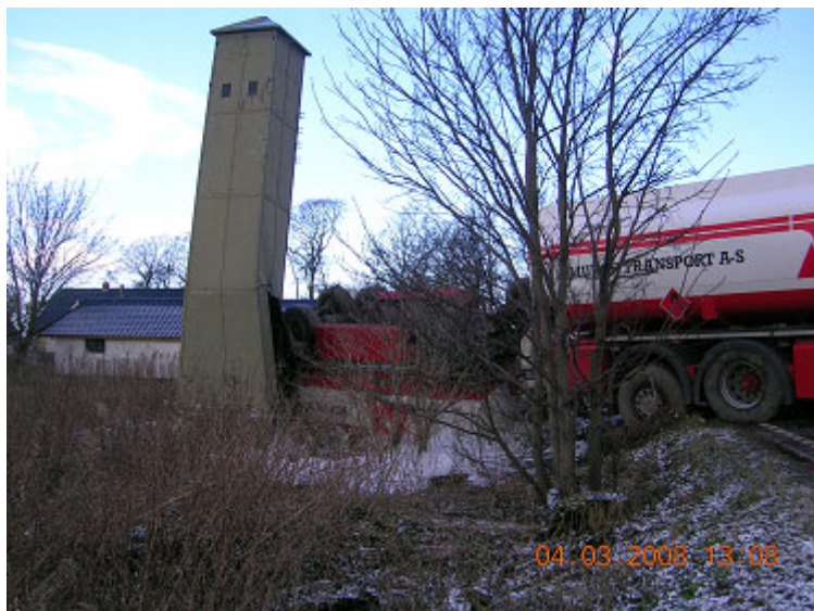
Foto13: Spild på Brandhøjgårdsvej 100
