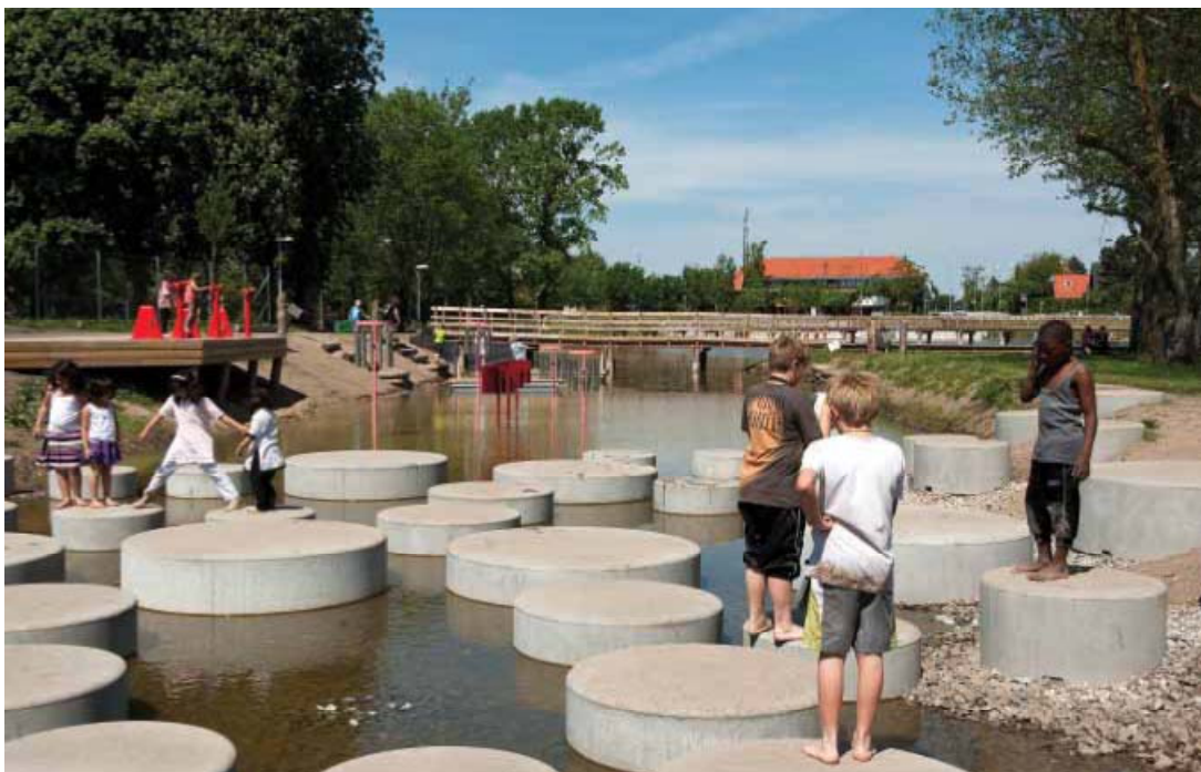
Selmose vand- og aktivitetspark, hvor Høje-Taastrup Kommune kombinerer indsats mod oversvømmelse ifm. store regnvands-hændelser og et rekreativt byrum
